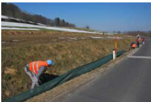
Slika 14: postavljanje varovalnih ograj za dvoživke ob cesti Cankova-Rogašovci
